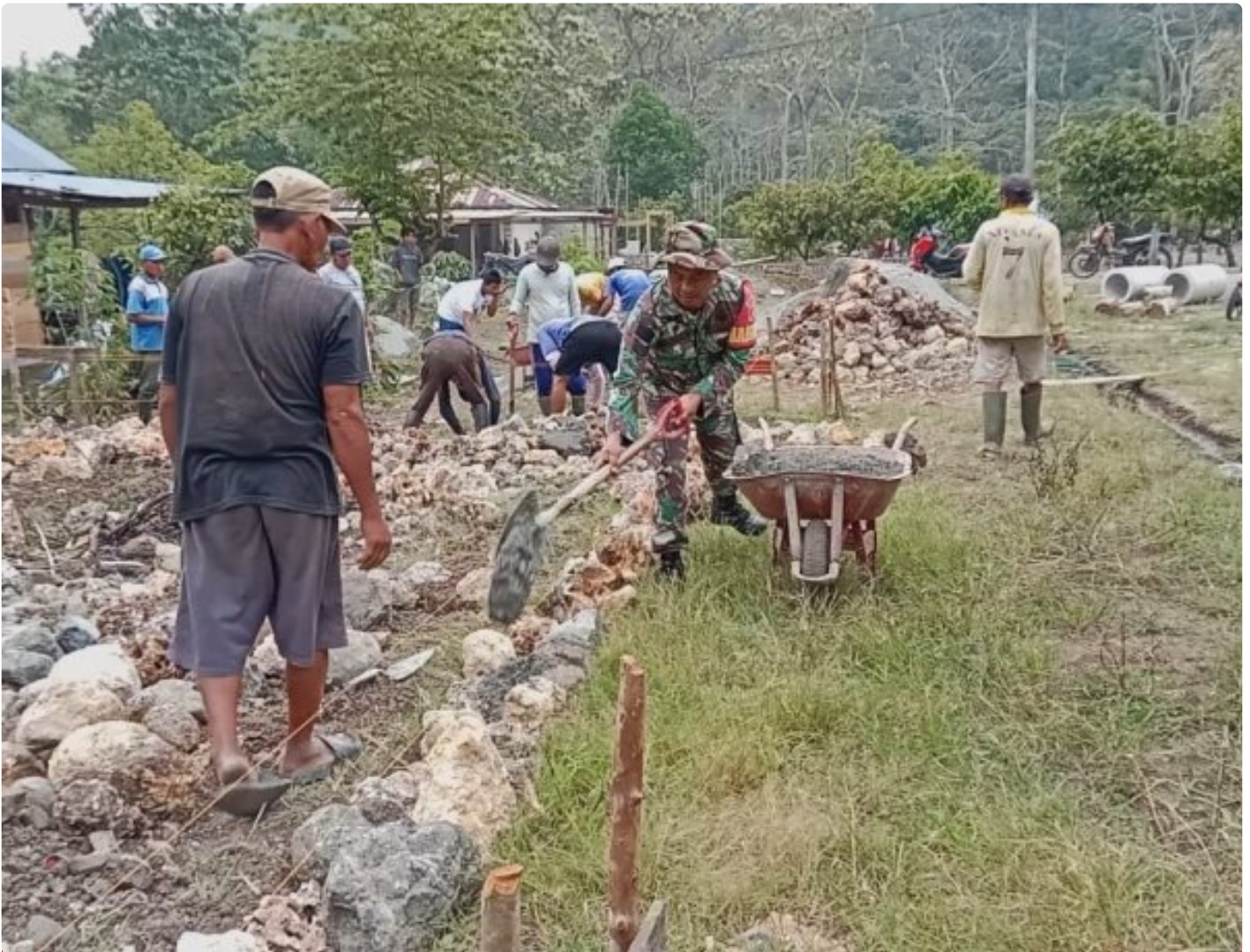
Gotong royong bangun pondasi rumah warga
