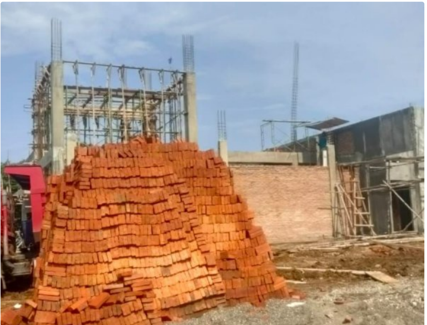
Tampak Pembangunan Kantor Inspektorat Morowali sedang berlangsung
