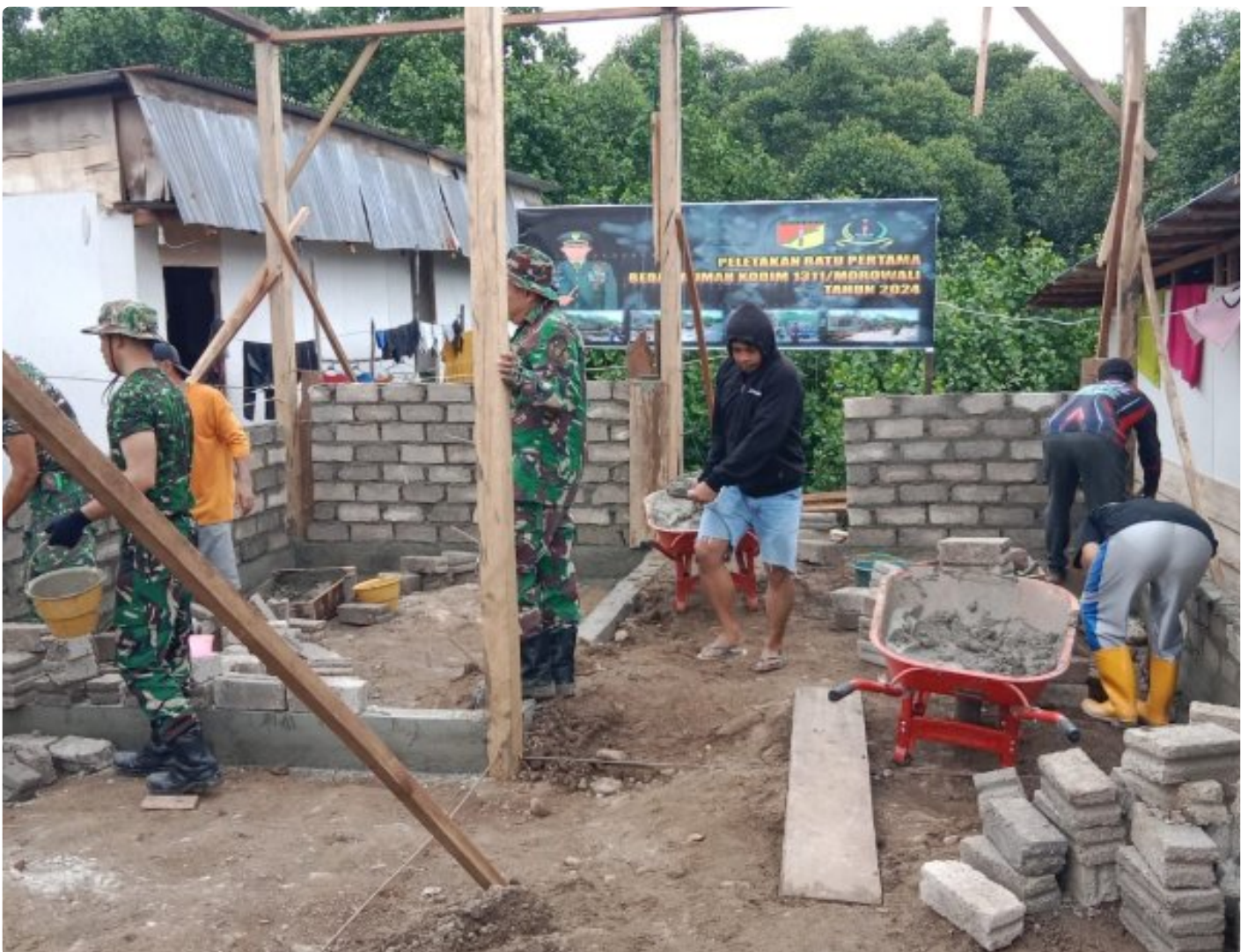
Tampak pengerjaan bedah rumah tahap pemasangan Batako
